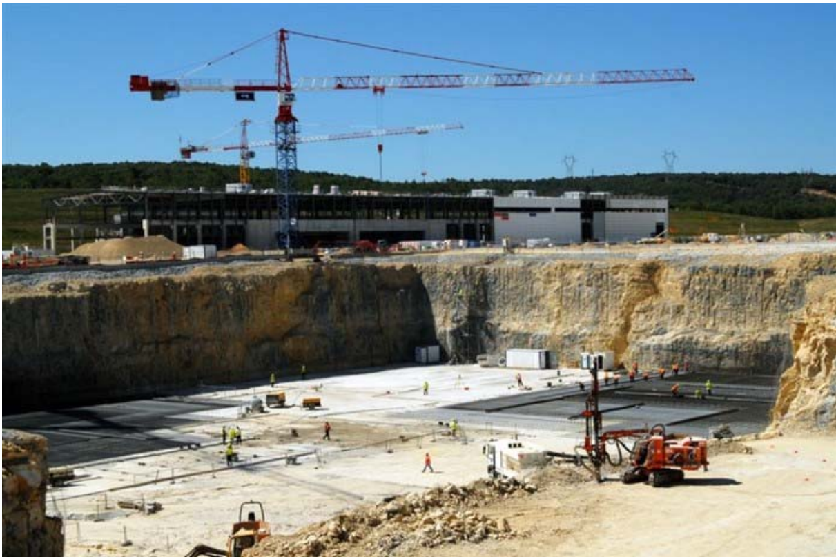
Werkzaamheden aan de vloer van het ITER tokamakgebouw (juni 2011). Op de achtergrond het gebouw voor het wikkelen van de poloïdale magneetveldspoelen.
